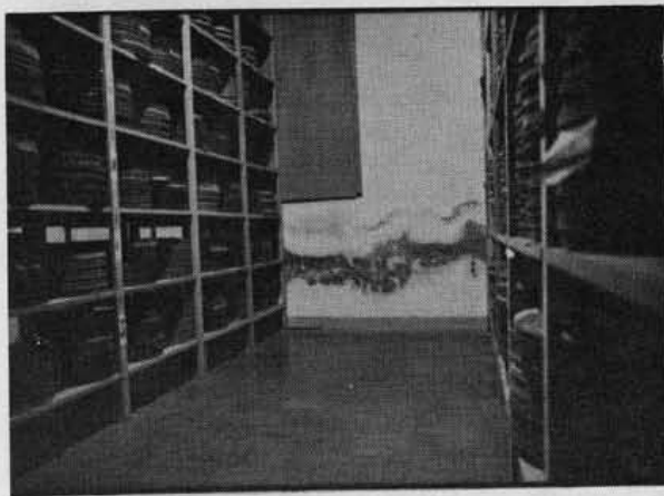
Depósito principal de filmes da Cinemateca Brasileira. Não há controle da temperatura ambiente, nem da umidade relativa, como se observa pela forte infiltração na parede.
