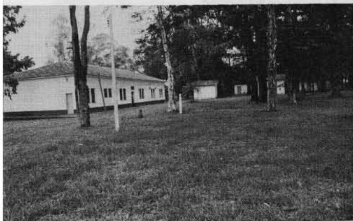
Acomodações precárias da Cinemateca Brasileira, no Parque Ibirapuera, São Paulo, onde está instalada há 20 anos. O prédio maior abriga o laboratório, o depósito de filmes de segurança e a administração.
