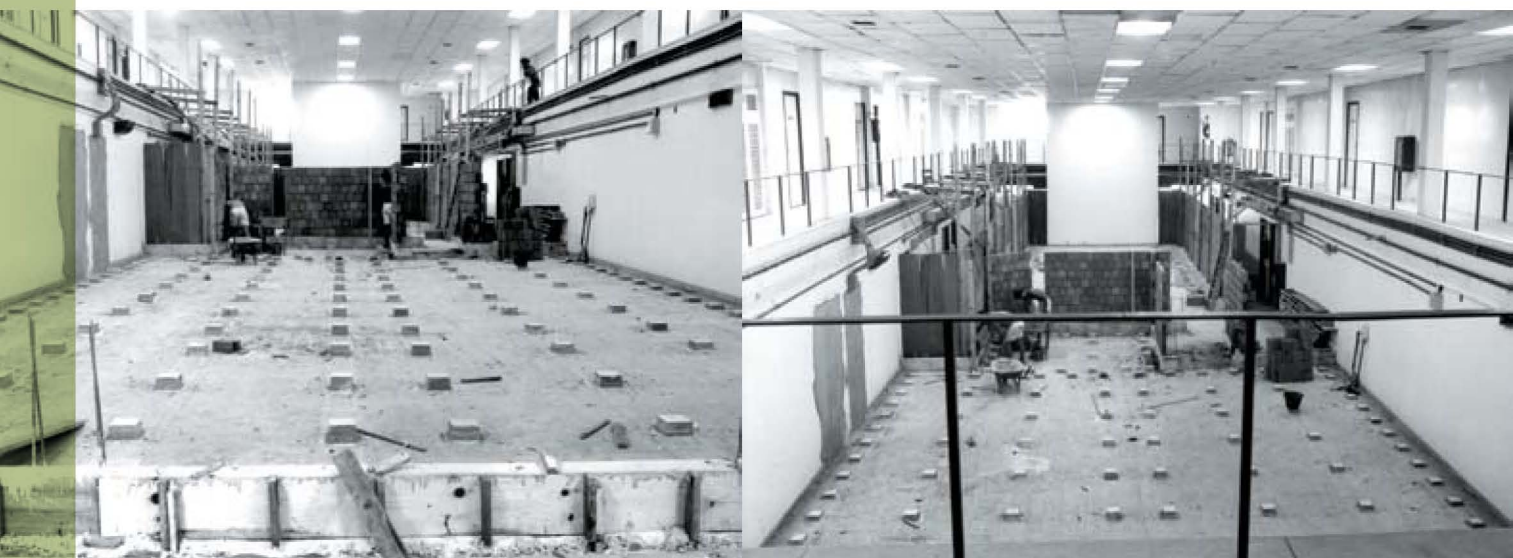
Construção do estúdio de som do CTAv
