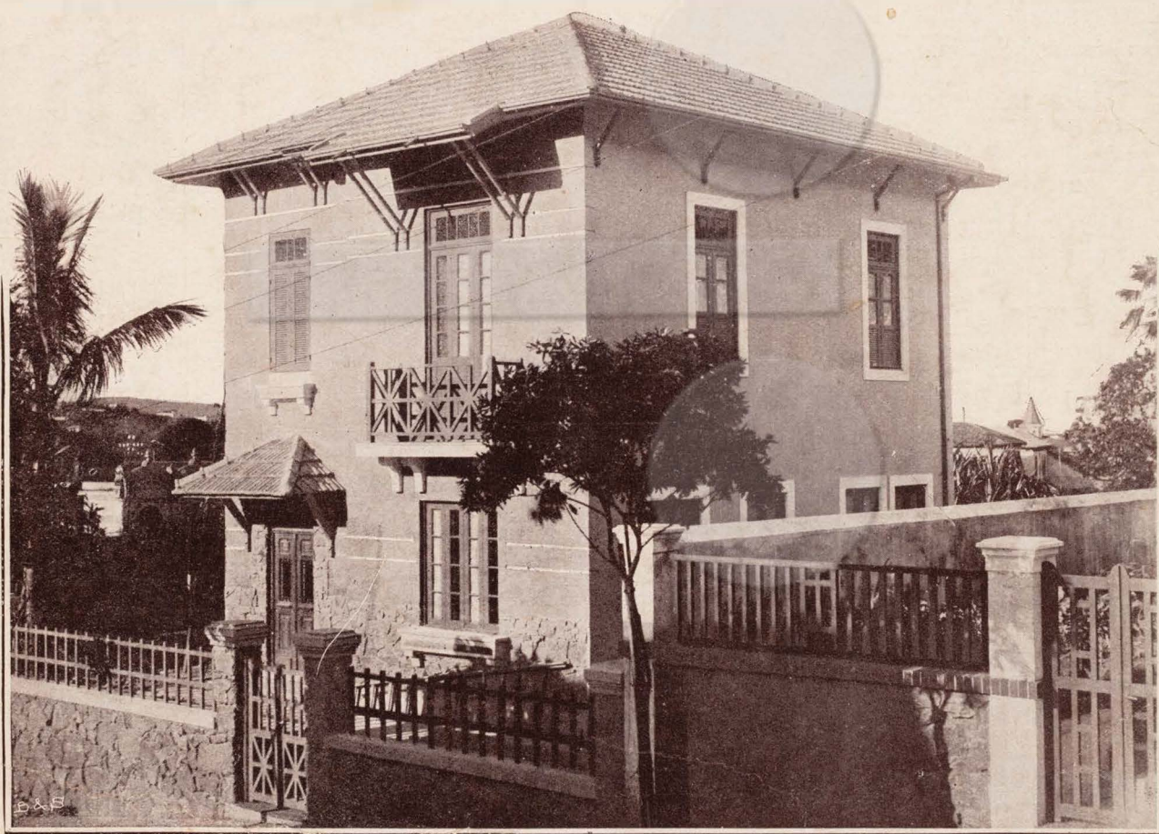
Predio construido pela Companhia á Rua da Cascata n. 11 -- TIJUCA
